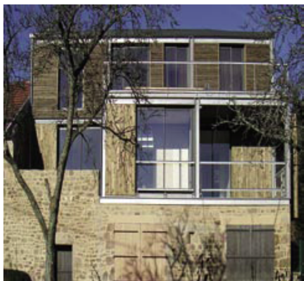
Opération de réhabilitation utilisant des éléments en acier
