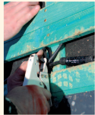
8 Liaison des câbles afin de limiter les aires de boucle induites, favorables aux impacts de foudre.
