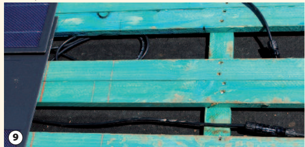
8 Liaison des câbles afin de limiter les aires de boucle induites, favorables aux impacts de foudre.
