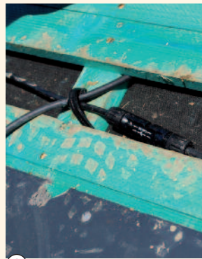
8 Liaison des câbles afin de limiter les aires de boucle induites, favorables aux impacts de foudre.
