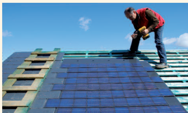
⑥ Pose de la 1ère colonne d'ardoises Solesia
