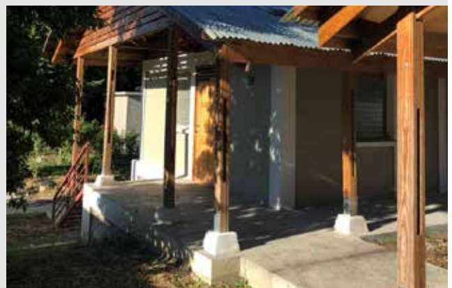
Haïti, Construction de l'Ecole Santo Port au Prince. Janvier 2019.
