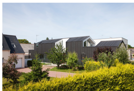
MAISON INDIVIDUELLE, CARQUEFOU (FRANCE)
