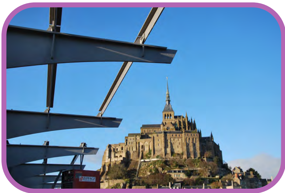
Passerelle d'accès au Mont Saint Michel
