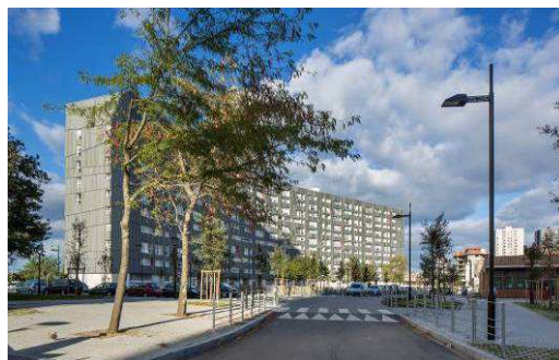
Immeuble Tchecoslovaquie, Nantes (France)
