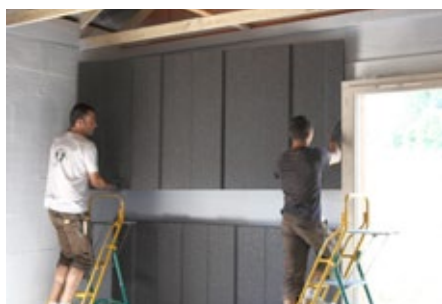
Pose de la vague isolante
