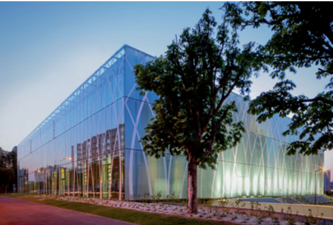
Médiathèque de Créteil © Chabanne &amp; Partenaires / Photographe : GG
