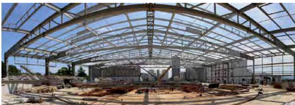
Une structure de 770 tonnes couvrant une aire de 6 000 m 2 sans poteau
