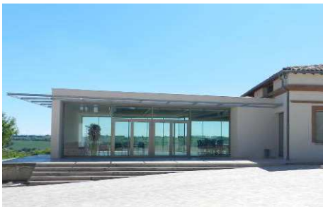
© EXTENSION FAÇADE NORD, PLACE DE L'ÉGLISE P. GUILBERT
