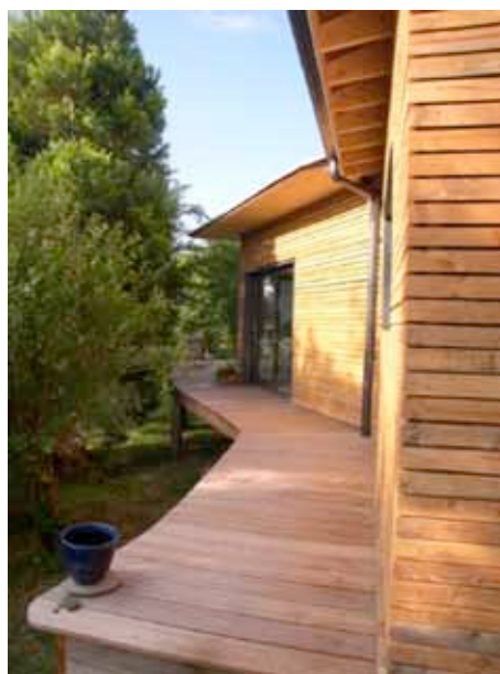
Construction maison individuelle ossature bois, Côte d'Or 21 Eric Guldemann, maître d'œuvre eOspace Chenôve
